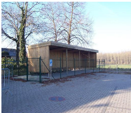
Bouw fietsenstalling zomer 2007
